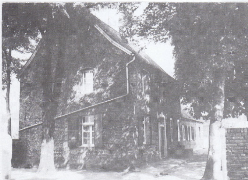
Die alte Kaplanei an der Fronhofstraße vor dem Abriß 1968
